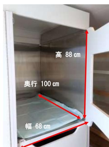
・「きたかみ」には、同型のペットボックス(内装はステンレス製)としてケージ(3列2段+2列2段)10台が設置されています。
